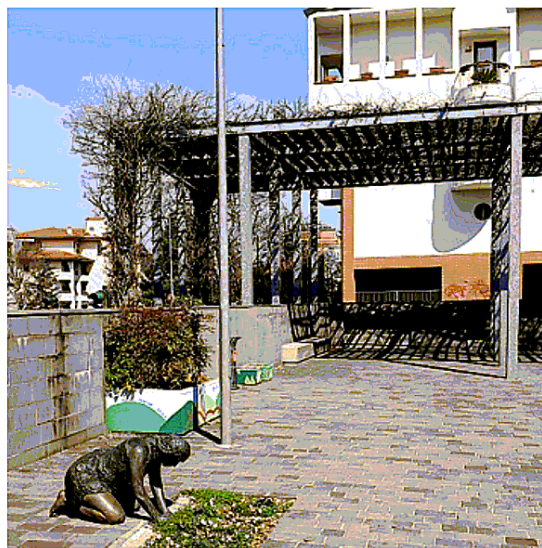
La zona soggetta alle infiltrazioni d'acqua Foto Boni
